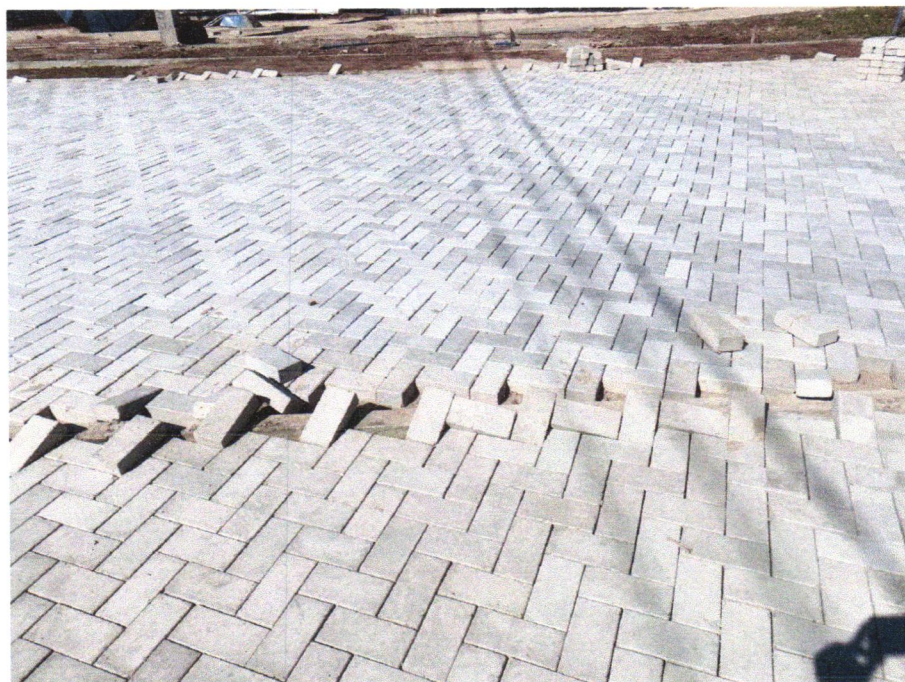
Foto 08 – EXECUÇÃO DE PASSEIO EM PISO INTERTRAVADO, COM BLOCO RETANGULAR COM NATURAL DE 20 X 10 CM, ESPESSURA 6 CM. AF_12/2015
