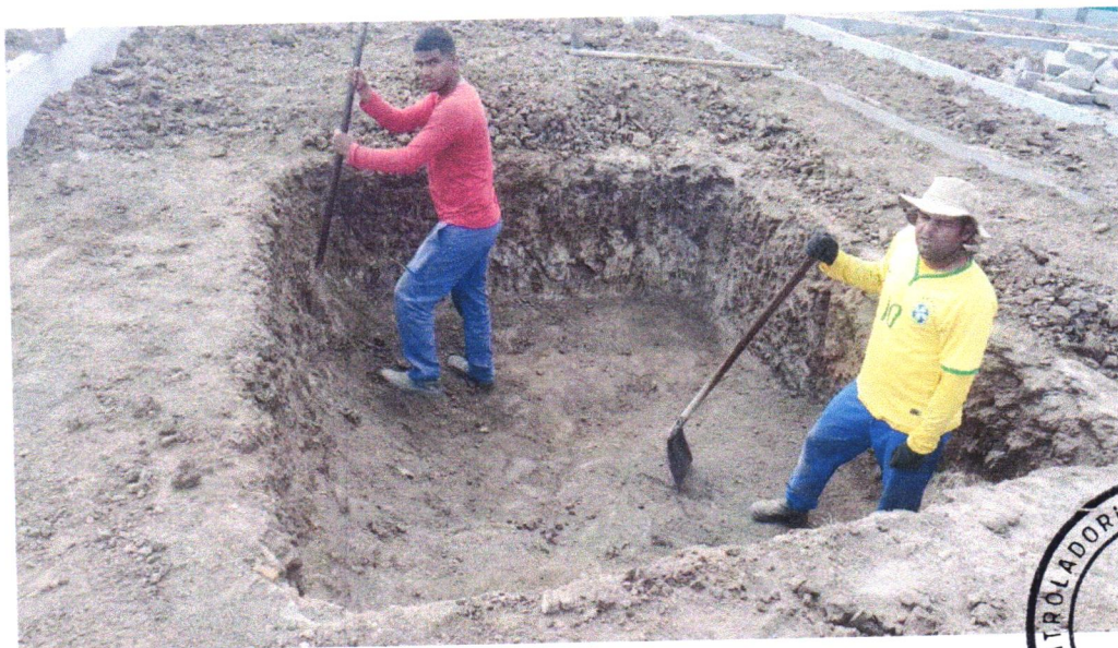
Foto 14 - ESCAVAÇÃO MECANIZADA DE VALA COM PROF. MAIOR QUE 1,5 M ATÉ 3,0 M (MÉDIA MONTANTE E JUSANTE/UMA COMPOSIÇÃO POR TRECHO), RETROESCAV. (0,26 M 3 ), LARG. DE 0,8 M A 1,5 M, EM SOLO DE 2ª CATEGORIA, EM LOCAIS COM BAIXO NÍVEL DE INTERFERÊNCIA. AF_02/2021
